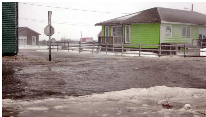
Miquelon :Dans la zone la plus inondée tout au sud, photo prise avec la côte dans le dos - 14/02/2017 - DTAM
